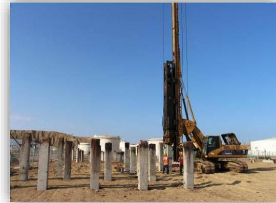
**Pilotaje:** Conjunto de pilotes hincados en tierra para consolidar los cimientos de las futuras unidades de proceso.
