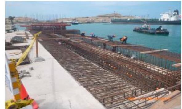
HABILITACION DE ARMADURA DE ACERO PARA VIGAS CANTIL Y LOSA DE FASE 9.
