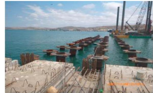
COLOCACION DE ENCOFRADO PARA EN APOYO DE MENSULAS.
