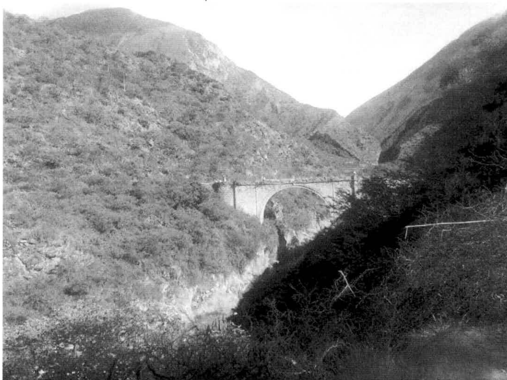
Foto: Vista panorámica del Puente Pachachaca
