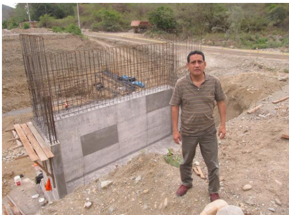
Supervisión de la construcción del puente en la carretera Perico-San Ignacio
