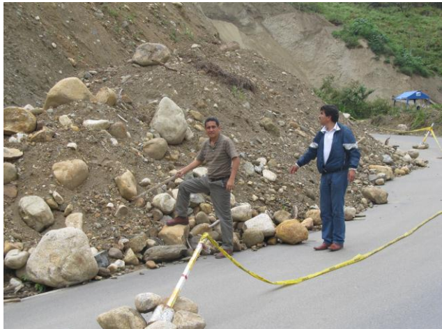
Supervisión de la carretera Namballe – San Ignacio.
