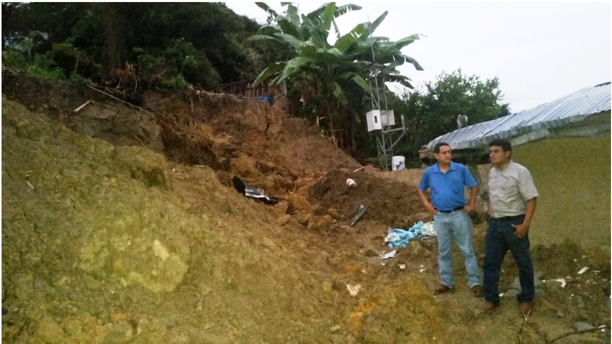
Verificación de familias damnificadas por deslizamiento de tierras en el Centro Poblado de Mesarrume, distrito de Choros, provincia de Cutervo.
