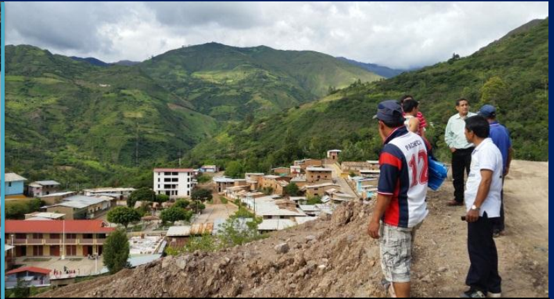
Visita de trabajo al distrito de Sallique (Jaén) junto al alcalde y otras autoridades de la zona. Aquí en la parte alta del derrumbe o deslizamiento que amenaza con sepultar al distrito de Sallique.
