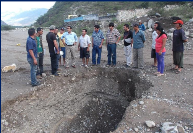
Mesías Guevara supervisando la obra de saneamiento en Lishinas, Distrito de Pucará, provincia de Jaén.
