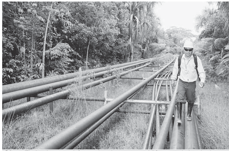
Obra. El oleoducto tendrá aproximadamente 207 kilómetros de longitud.
