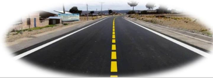
PIP DE INFRAESTRUCTURA VIAL CONSIDERADOS EN EL PMI DEL MTC 2020-2022
