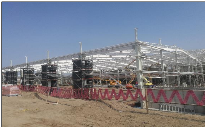
Pintura intumescente y torqueo de estructura metálica en Zona de Calentamiento
