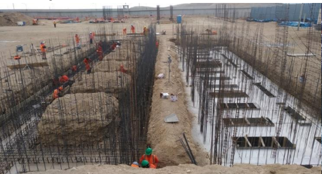
Obra EP Chincha
