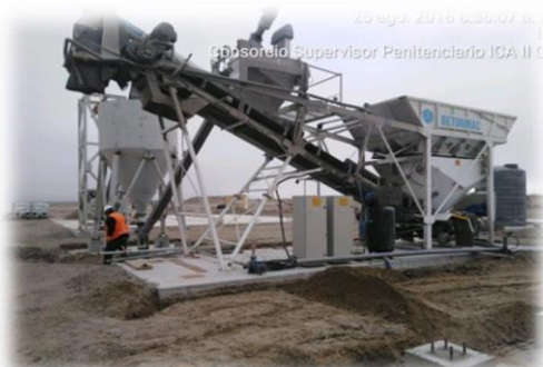
MONTAJE DE PLANTA DE CONCRETO
