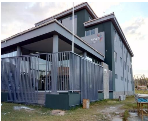
Obra – Sede Registral Cajamarca
