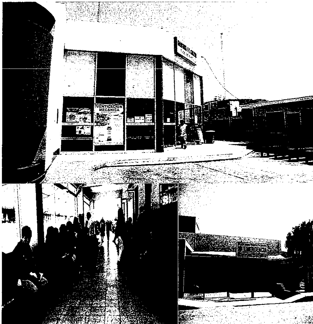
Imágenes actuales de la infraestructura del Hospital la Caleta
