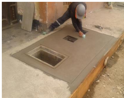
Reposición de vereda de concreto en la Calle Bolívar.
