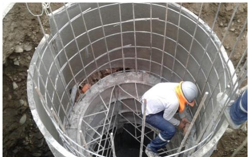
Armado de acero en buzón de la red de alcantarillado – Calle Bolívar
