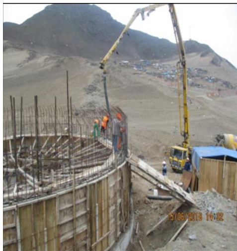
Vaciado del fuste del reservorio
