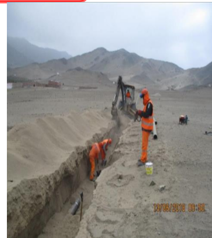
Excavación, preparación de cama e instalación en la línea de conducción.
