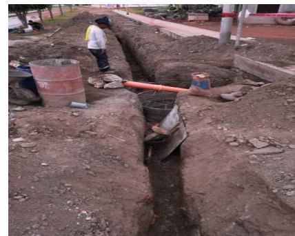
Construcción cámara para válvula de aire y red de agua potable - Calle Jazmín (empalme a Red de Urb. Las Mercedes)
