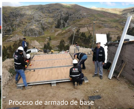
Proceso de armado de paneles
