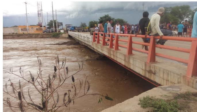
Puente río La Leche.
